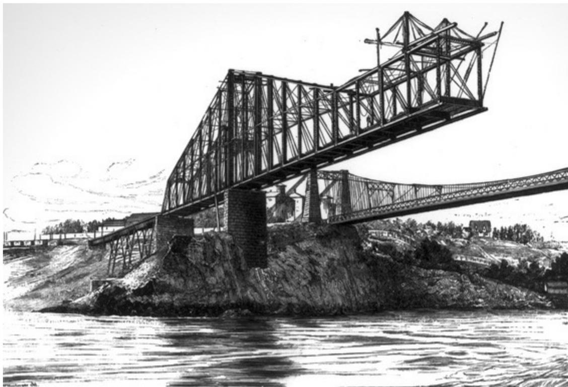
Figura 12. El puente en ménsula (cantilever) en construcción que cruza el río St. John en New Brunswick demostró un principio estructural claramente diferente al del puente colgante. (De Scientific American, 1885.)
