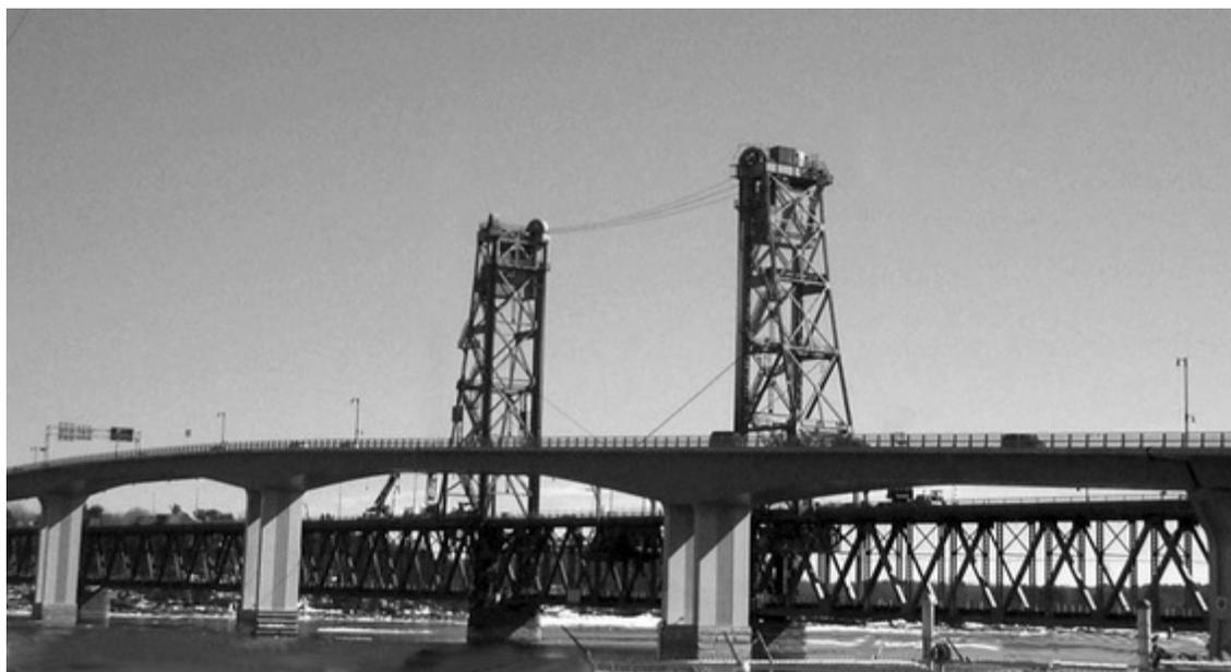
Figura 15. Un puente de viga tubular de concreto postensado que cruza el río Kennebec en Bath, Maine, ofrece más espacio y carriles de circulación que el estrecho puente anterior, que ahora sólo soporta el paso ocasional del ferrocarril. (Fotografía de Catherine Petroski.)
